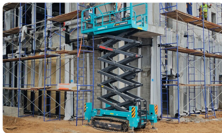
Гусеничный подъёмник на стройке
